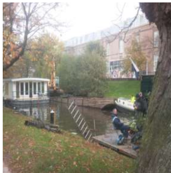
Alle baggeractiviteiten bij elkaar. De bak, de graafmachine, de duikers en op de kade de gevonden fietswrakken.
