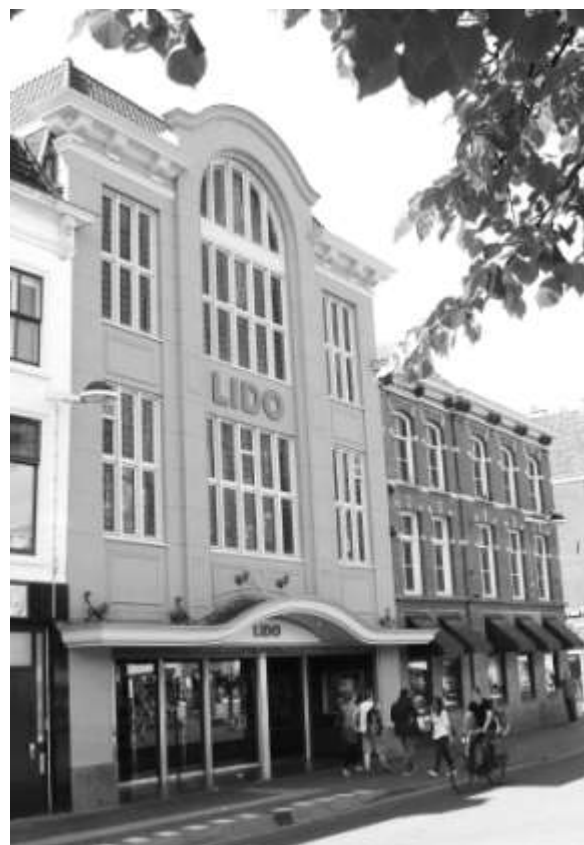
Resultaat van de reconstructie van de gevel van pand 39 naar de tekeningen van 1934
